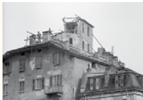
Dégâts liés au séisme de 1946, maison Reynard, Sion. photos: Raymond Scherrer/Bourgeois de Sion, Médiahaque/Valais - Martigny
