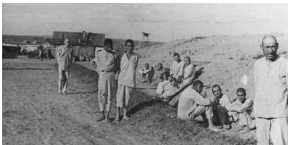
Travail de creusement. Photo Alexandre Rodchenko. Belomorkanal, 1932. GARF
